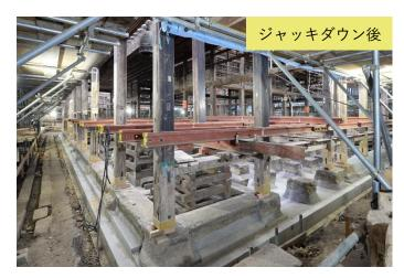
写真で見比べてみると、基礎や柱の補修・補強がしっかりと為されていることが分かります。地盤沈下や地震などの自然現象に対する備えも、文化財建造物を長く残していくためには重要なことです。
