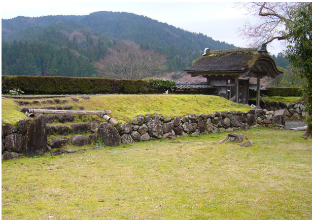
〔写真 4-5〕 土塁の石垣と階段【構造物】
