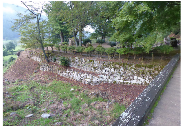
〔写真 4-4〕 空濠石垣【構造物】
