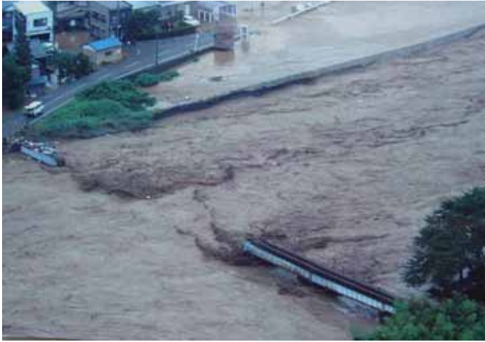
流失したJR鉄橋 福井市安波賀町
