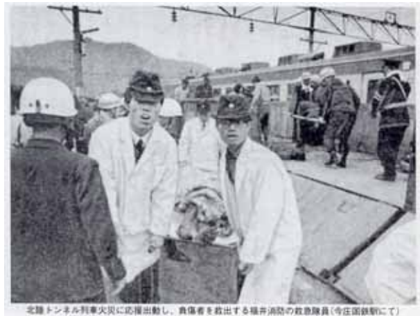
北陸トンネル列車火災に応援出勤し、負傷者を救出する福井消防の救急隊員(寺庄国鉄駅にて)
