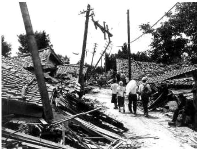
した森田町の様子 地震により住宅が倒壊
