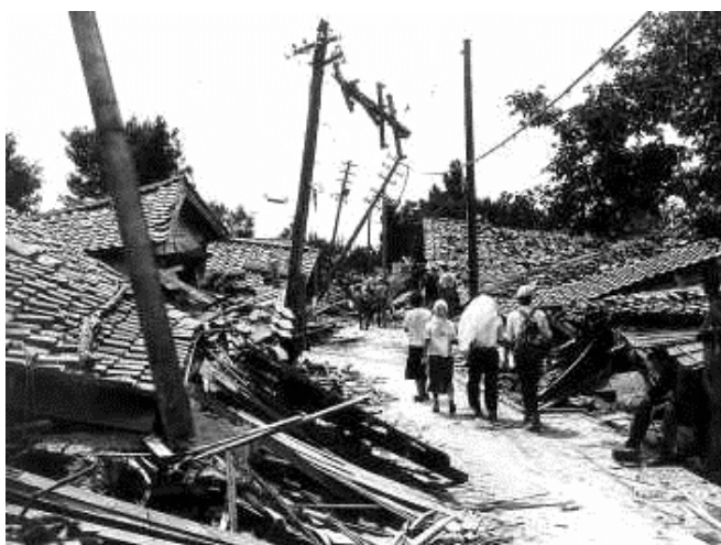
地震により住宅が倒壊した森田町の様子
