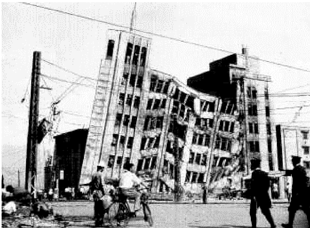
福井地震により倒壊寸前の被害を受けた大和デパート
