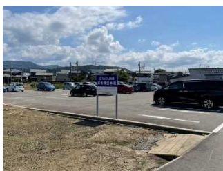
■越前島橋駅 P&R 駐車場整備
