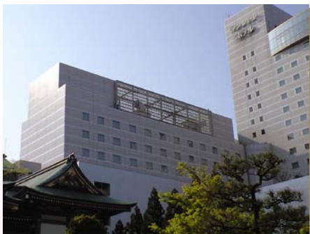
(例9) 屋上設備の隠蔽の例
