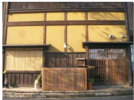
(例10) 屋外設備の隠蔽の例
