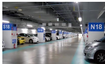
福井駅西口地下駐車場
