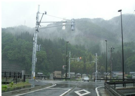
信号機の設置
