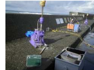
防波堤の改修
