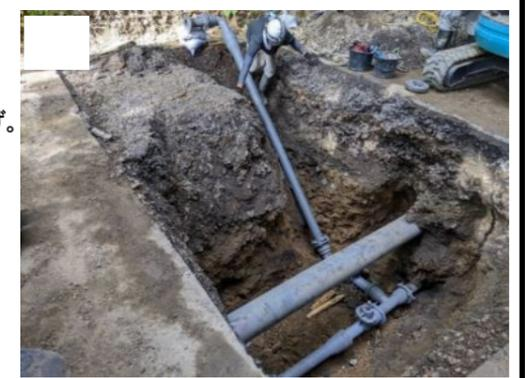
連絡A 既設管から分岐し、露出管との接続部を立ち上げ。
