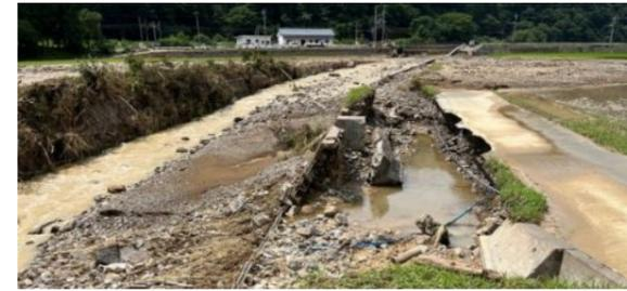
堤防道路が洗堀され、水道管が破断
