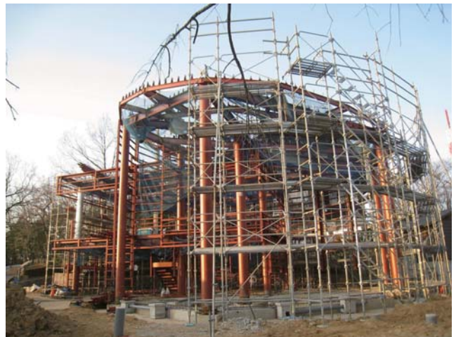
建設工事の様子（3月）
