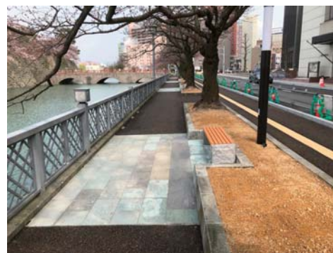
堀端通りの整備状況
