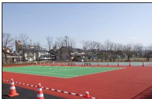
公園施設リニューアル (板垣中央公園 テニスコート改修)
