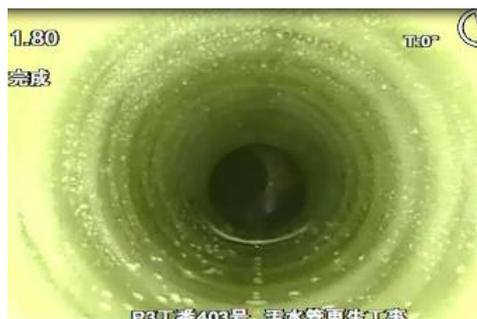
既設管内に新規管を設置（管更生）
