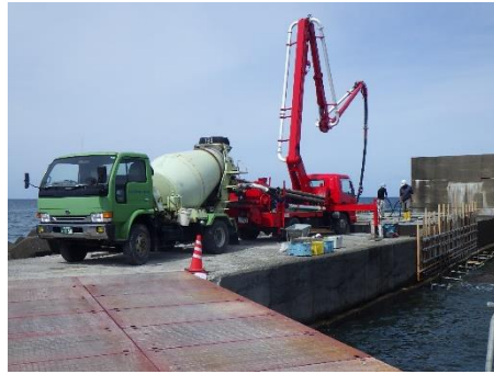
鮎川漁港の改修
