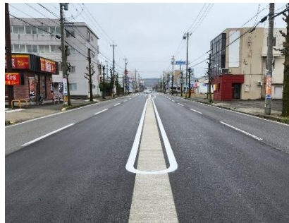
消雪施設の整備
