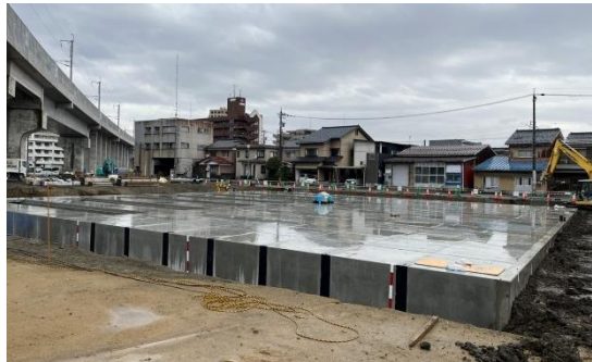
調節池本体工事
