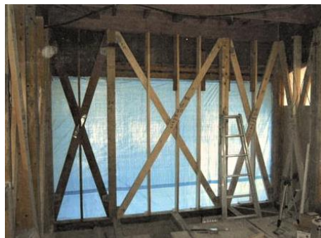
耐震化事例 (筋かい新設)
