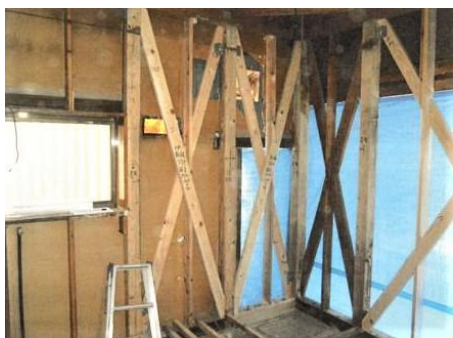
耐震化事例 (筋かい新設)
