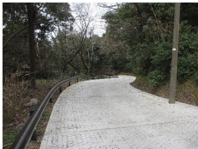
足羽山公園 園路舗装
