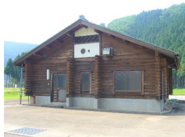
品ヶ瀬地区 農業集落排水処理施設
