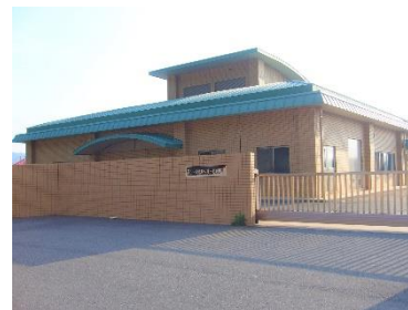
蒲生・茱崎地区 漁業集落排水処理施設
