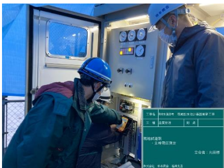
計装盤を更新した時の様子 （配水施設）
