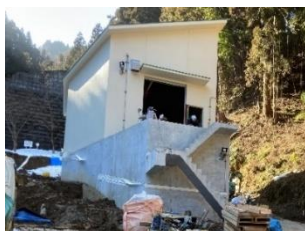
浄水場建築工事の様子
