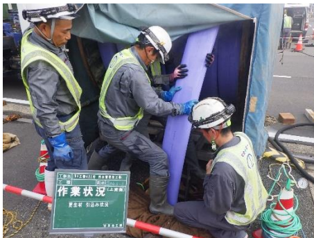
管更生による耐震化工事の施工状況 （管更生材の挿入）
