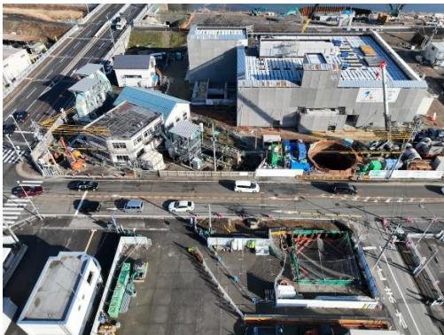
加茂河原ポンプ場 現況写真
