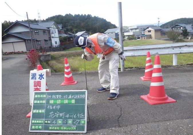
漏水調査の様子
