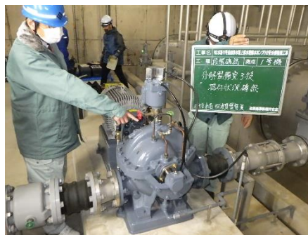
揚水ポンプを更新した時の様子 （送水施設）
