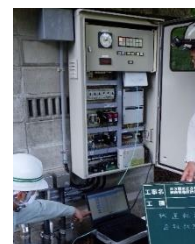
遠方監視装置設置工事の様子
