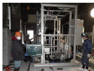
設備設置工事の様子
