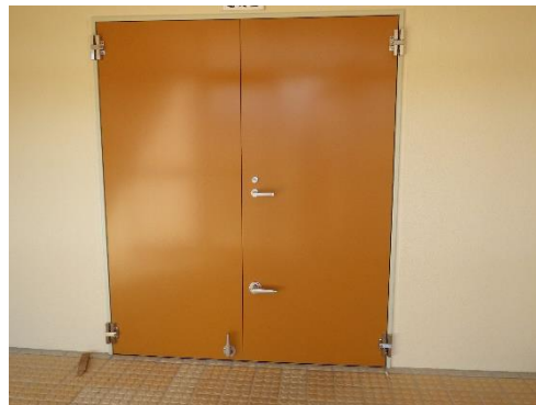
耐水扉設置の様子
