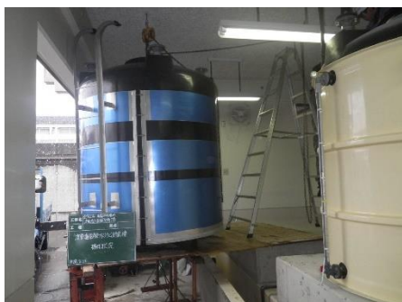
次亜貯蔵槽を更新した時の様子 （浄水施設）
