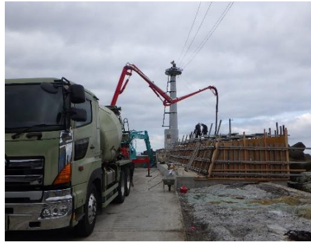
白浜（国見）漁港の改修
