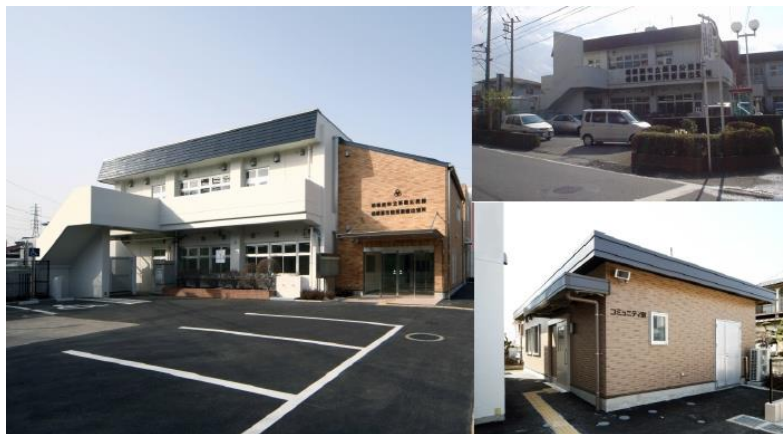
新磯公民館（左：改修後、右上：改修前、右下、増設部）
