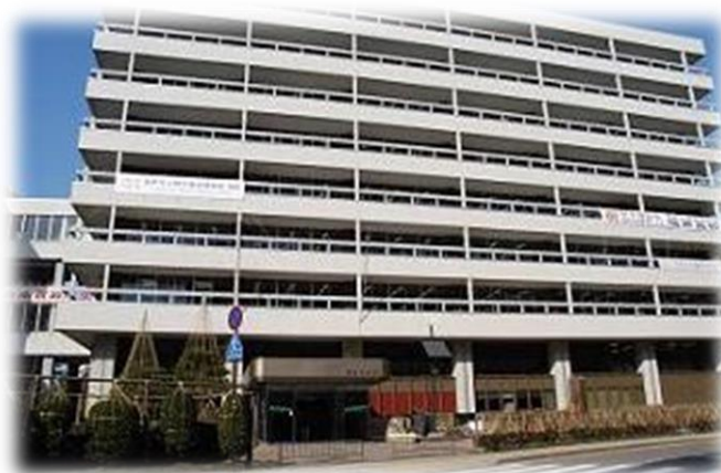
『写真：庁舎（本館）』
