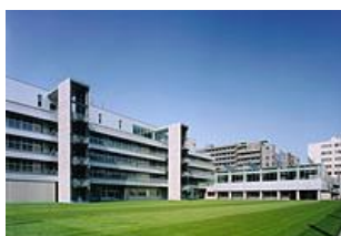
資生館小学校の外観
