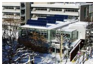
屋上に設置した太陽光パネル
