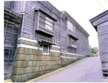
北海道江差町 回船問屋旧中村家の土台
