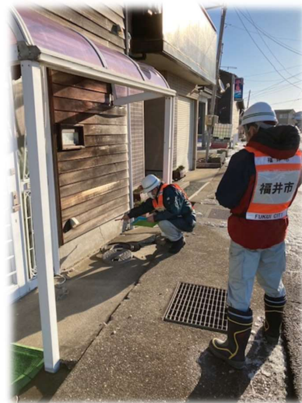
<被災地にて住宅の状態を確認している職員>
