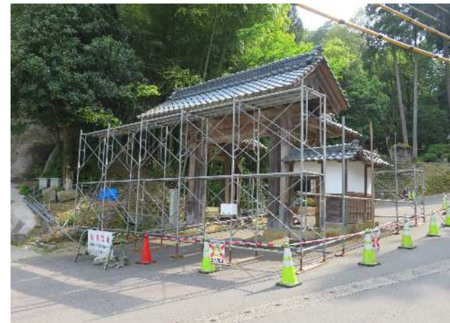
素屋根棚足場 組立て中
