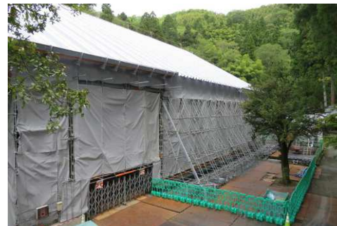
素屋根 建設完了
