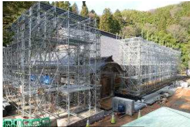
素屋根棚足場 組立て中
