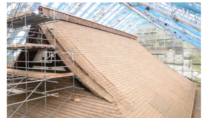
棧瓦葺 解体完了
