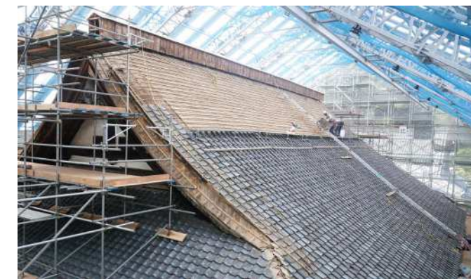
棧瓦葺解体の様子
