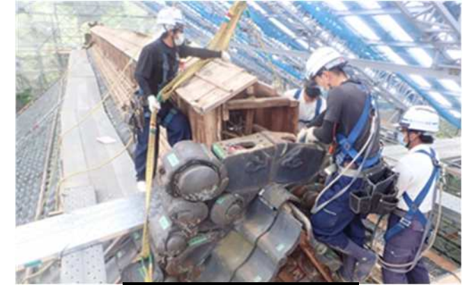
鬼瓦解体の様子
