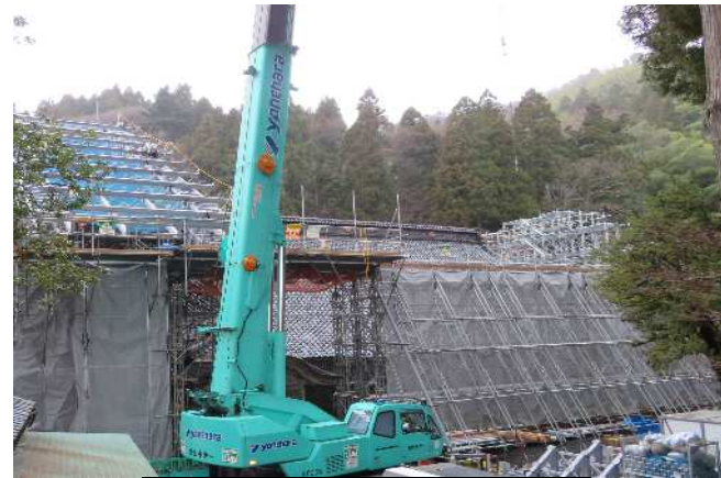
素屋根骨組 組立て中
