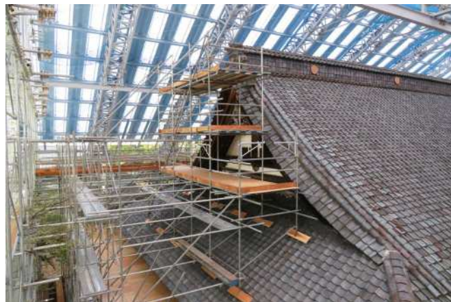
素屋根妻足場 組立て中
