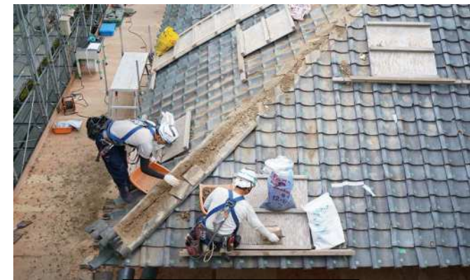
隅棟解体の様子
