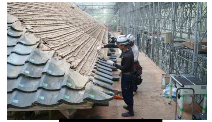
軒先解体の様子
