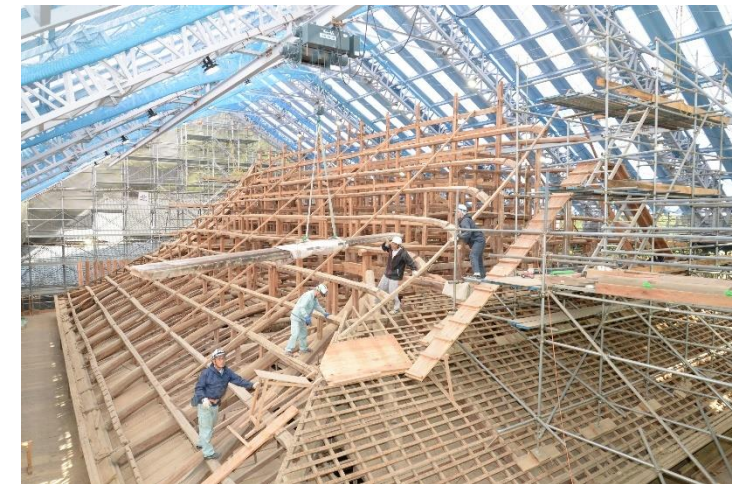
破風板 取り外し中
