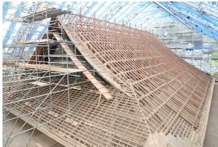
屋根下地 解体完了
