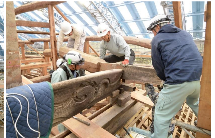
妻側木部 解体中
