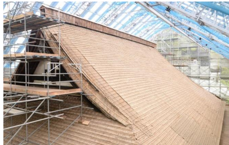
葺瓦 解体完了
