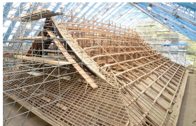
野垂木 取り外し中
