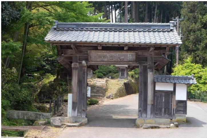
修理前写真(正面)
