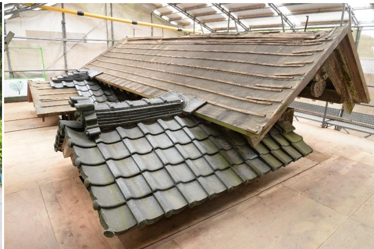
棧瓦葺 解体中
