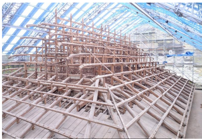
妻側木部 解体完了
