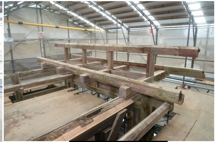
小屋組 解体中
