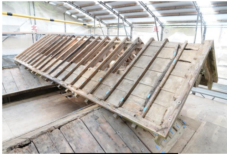
屋根下地 解体完了
