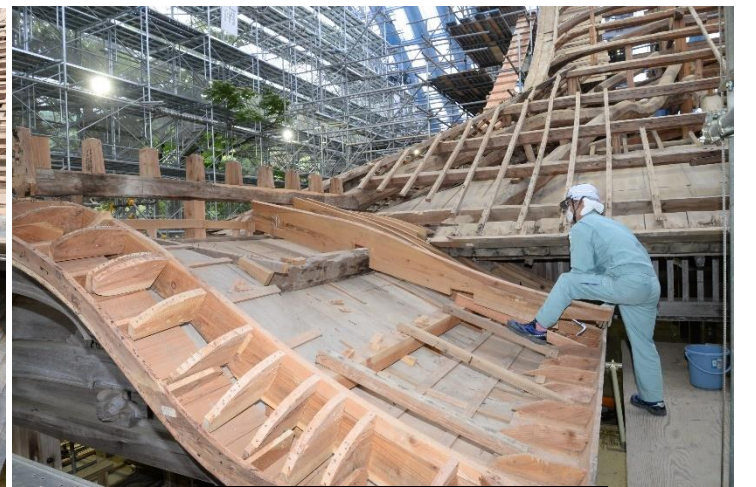
玄関 屋根下地解体中
