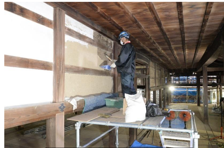
漆喰壁 掻き落とし中
