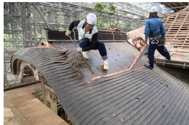
玄関 銅板葺解体中
