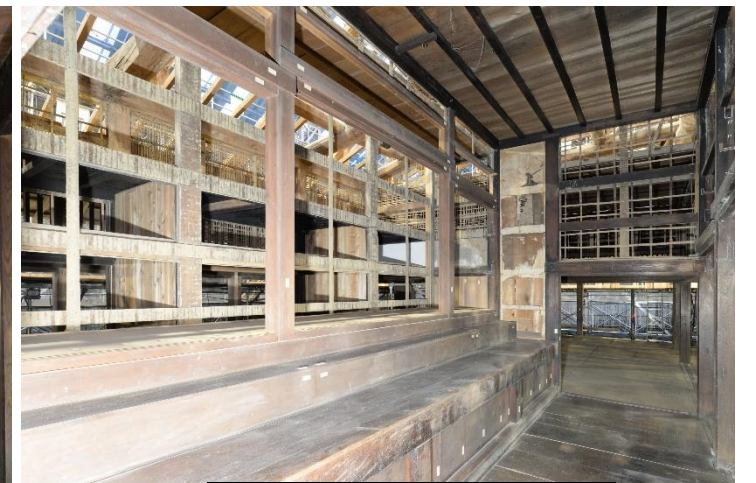
仏壇漆喰壁解体 完了
