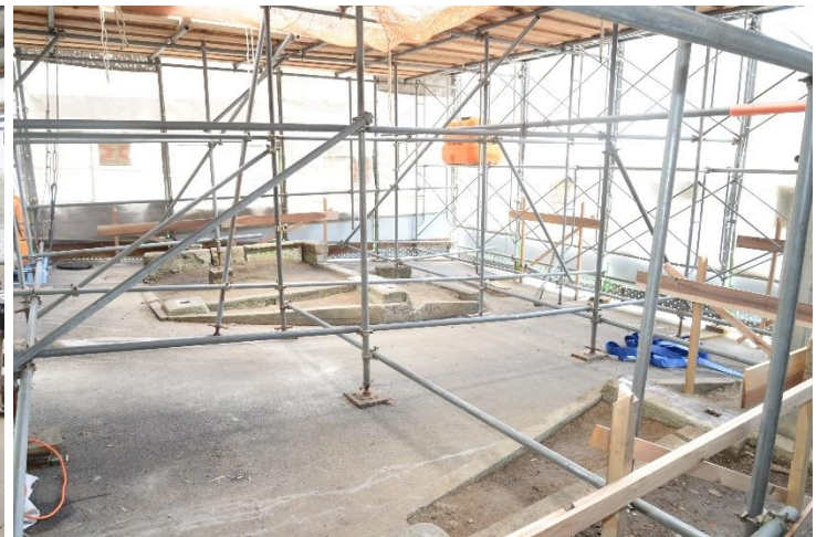
木部 解体完了
