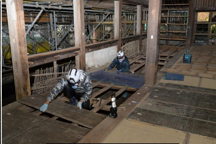
広縁 床板取り外し中
