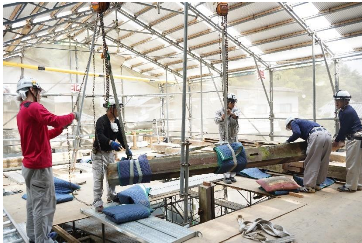
本柱 取り外し中
