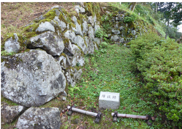
〔写真 4-17〕 土留め石垣と階段【構造物】
