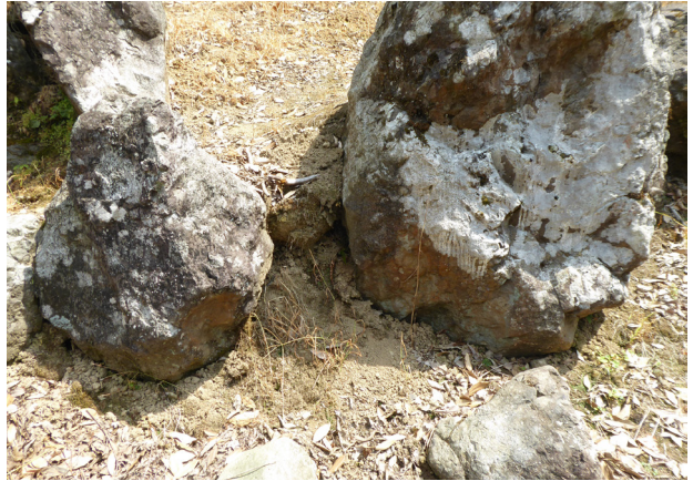
【写真 4-36】 表土の洗掘【地割・地形】
