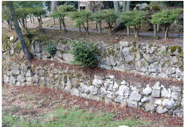
[写真 4-34] 空濠石垣【構造物】
