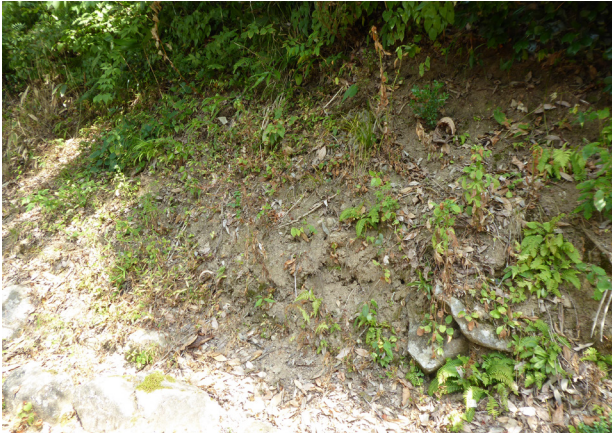
【写真 4-35】 斜面地の洗掘【地割・地形】
