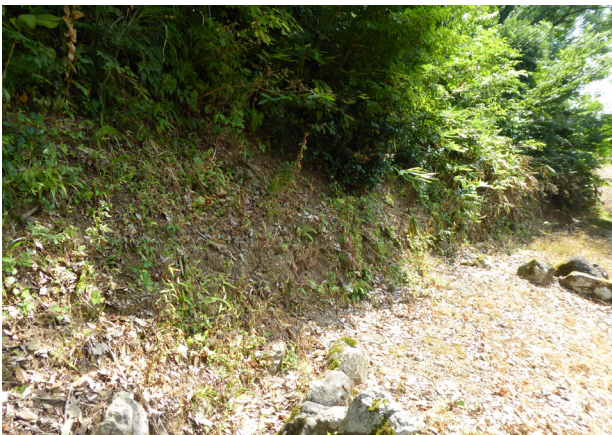
【写真 4-39】 水路への土砂堆積、不明瞭化【水系】
