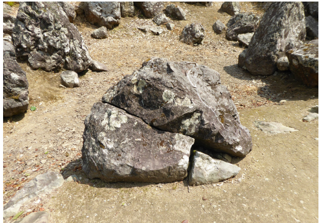
【写真 4-38】 景石の割れ【石・石組】
