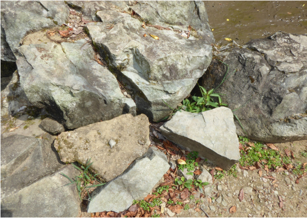
【写真 4-51】 橋石の割れ【石・石組】
