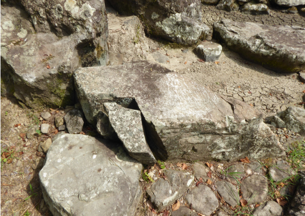
【写真 4-53】 景石の割れ【石・石組】
