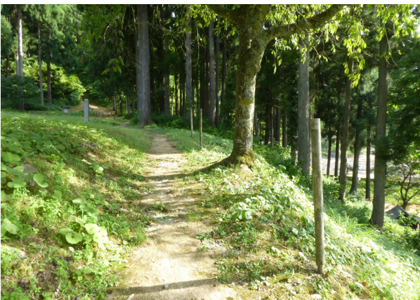
[写真 4-71] 転落防止対策の未整備【本質的価値を補完する要素】
