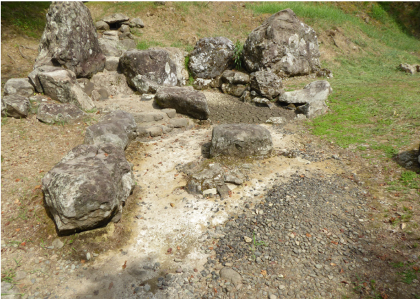
【写真 4-55】 流路底の劣化【水系】
