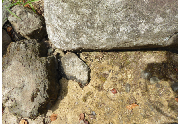
【写真 4-54】 流路底の損傷【水系】
