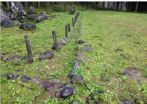
【写真 4-65】 侵入防止柵・溝 【本質的価値を補完する要素】
