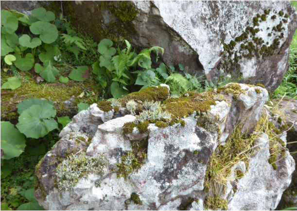
[写真 4-67] 景石の割れ【石・石組】
