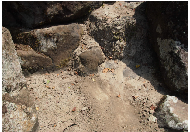
【写真 4-56】 滝石組前の底石埋没【水系】
