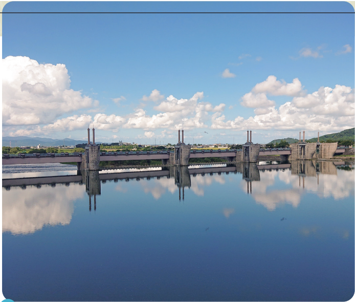
8 九頭竜川鳴鹿大堰 | 永平寺町 | 九頭竜川鳴鹿大堰は、九頭竜川が山地に挟まれた谷平野をぬように流れ福井平野に出たところに立地しており、山地と河川とが織りなす素晴らしい景観を形成しています。また、歴史的にも、六呂瀬山、手繰ヶ城山等の県下有数の古墳群に囲まれ、古くから河川とともに栄えた地域です。夏には九頭竜川の風物詩である、鮎釣りの風景を見ることもできます。
