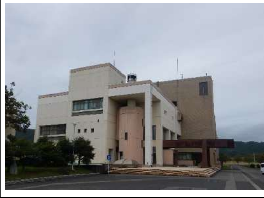
日野川浄化センター
