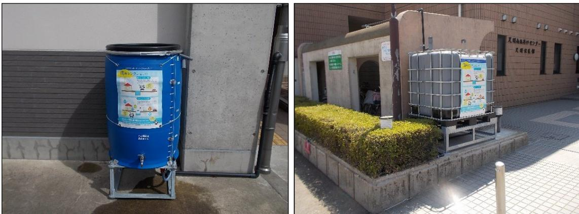
図 5.10 各戸貯留(雨水タンク) イメージ
