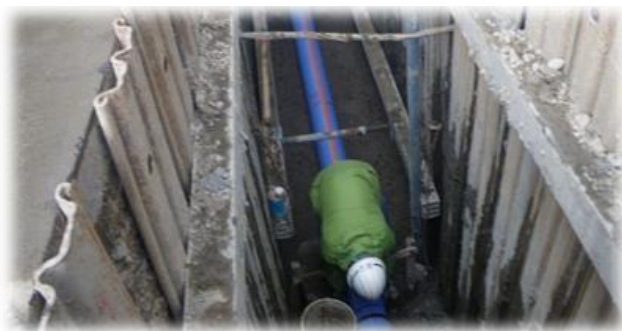
<污水管の布設>
