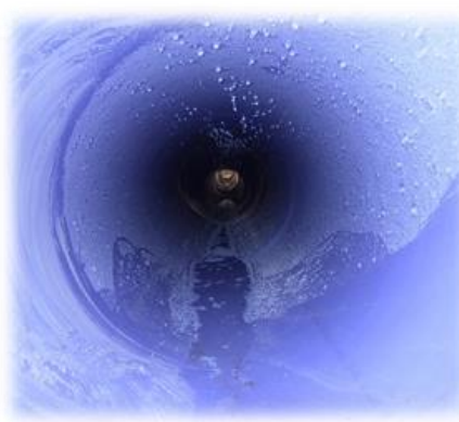
<管更生後の下水管の内部>
