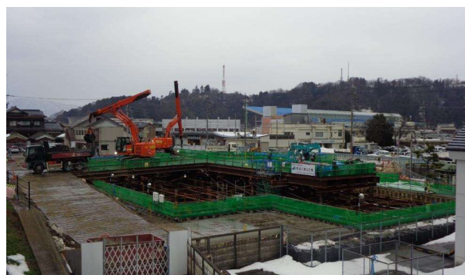
加茂河原ポンプ場の更新
