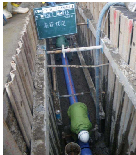
污水管の敷設
