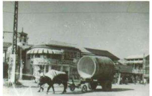
昭和期の下水道管敷設の様子
