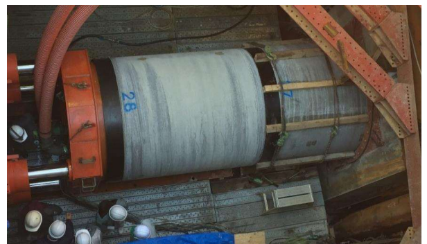
バイパス管の整備
