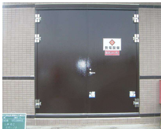
自家発電機室への防水扉の設置
