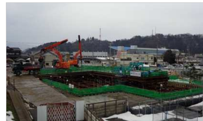
<加茂河原ポンプ場更新工事>
