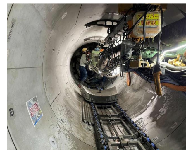
<工事の状況（足羽雨水増補幹線）>
