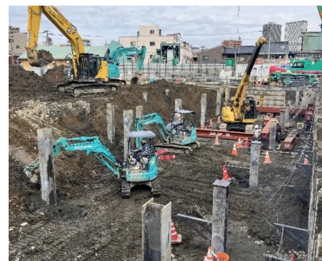
<工事の状況（ポンプ場建屋）>
