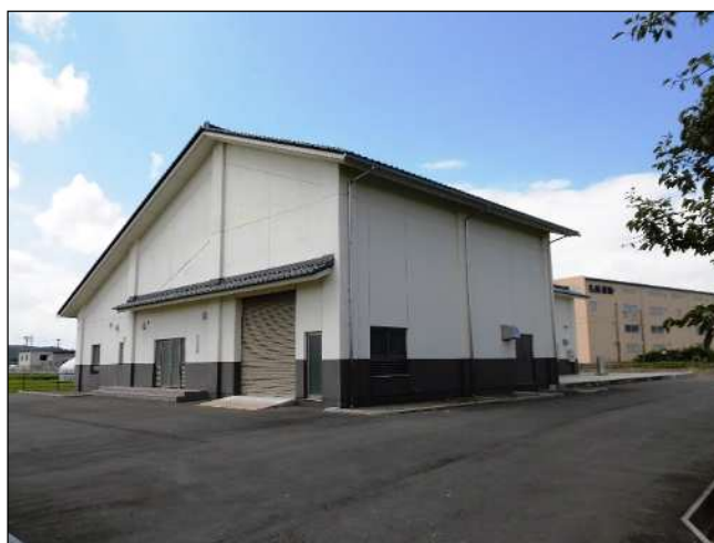
【文殊地区農業集落排水処理施設（平成 26 年供用開始）】
