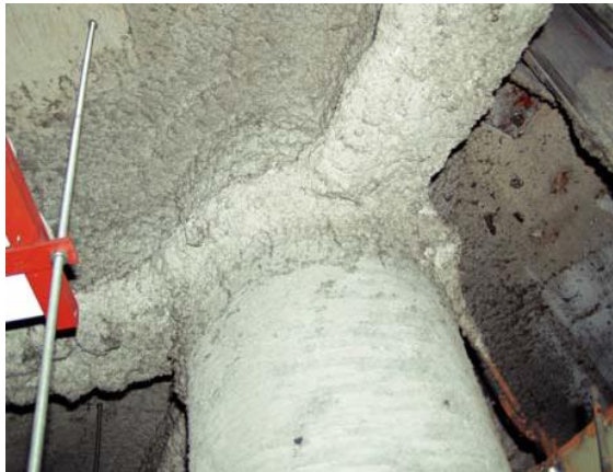
鉄骨の柱や梁に耐火被覆として使用された例
