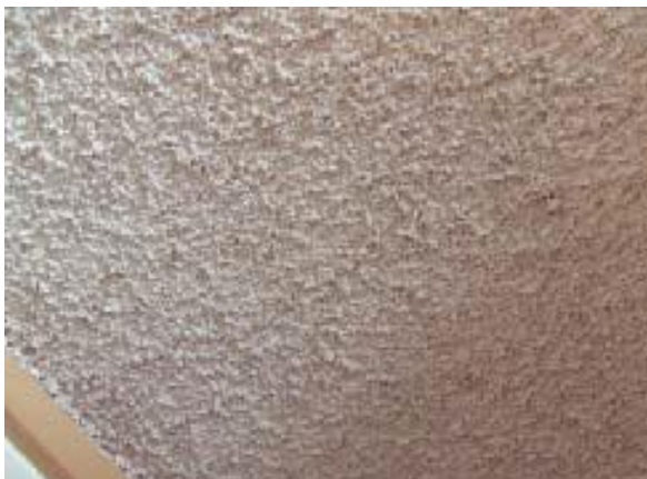
仕上塗材として天井に使用された例
