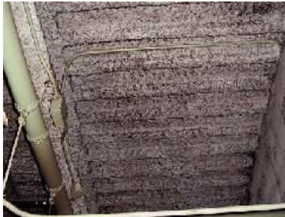
天井断熱材として使用された例
