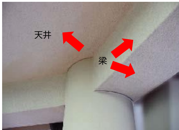
仕上塗材として天井や梁に使用された例
