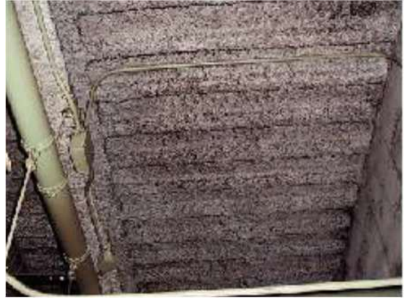
天井断熱材として使用された例
