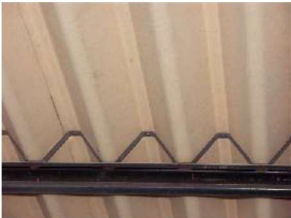
屋根裏に使用された例
