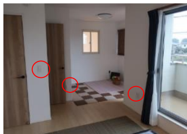
写真Ⅱ.50 主寝室（手前）と一体的に設けられた子ども部屋（奥）。将来の部屋の分割に備えて、ドアや電気スイッチ・コンセントを配置
