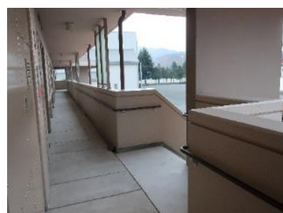
写真Ⅱ.64 子どもの使いやすさに配慮した高さに 設置された手すり
