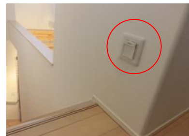
写真Ⅱ.20 階段の段差位置を確認できる場所に設置された足元灯
