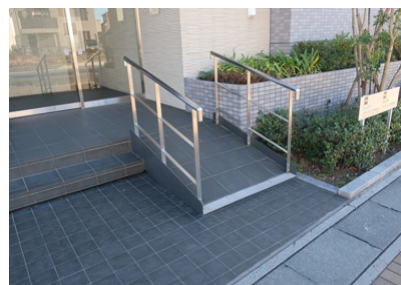
写真Ⅱ.54（右上）、写真Ⅱ.55（右下） ベビーカーでの移動にも配慮された住棟 エントランスに設置されたスロープ
