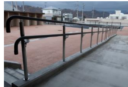
写真Ⅱ.66 子ども用手すりが設置された 2 段手すりのスロープ
