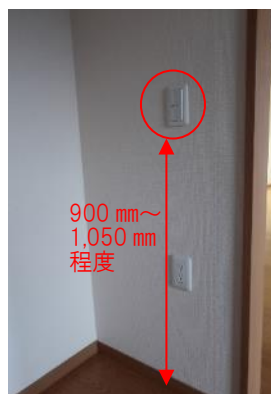
写真Ⅱ.9 子どもの手の届きやすい高さ（床上1,050mm以下）に設けられた電気スイッチ
