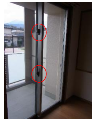
写真Ⅱ.5 2か所（1か所は小さな子どもの手の届かない高さ）に取り付けられたクレセント錠
