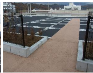
写真Ⅱ.83 住棟まわりの歩行者専用スペースから駐車場への歩行者道は同じ色彩の仕上げ材を用いている
