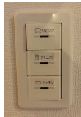
写真Ⅱ.10 絵や文字も添えられた分かりやすいワイドスイッチ
