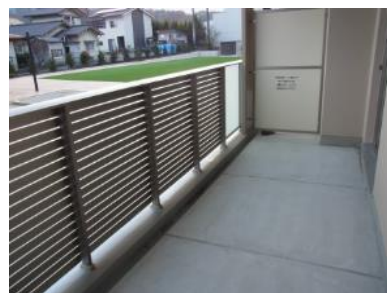
写真Ⅱ.51 バルコニーの転落防止に配慮された手すり
