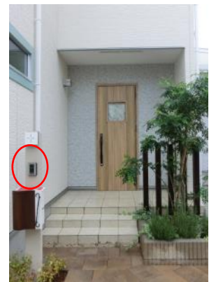
写真Ⅱ.13 敷地境界部分に設けられた 住宅内との通話機能を有する カメラ付きインターホン
