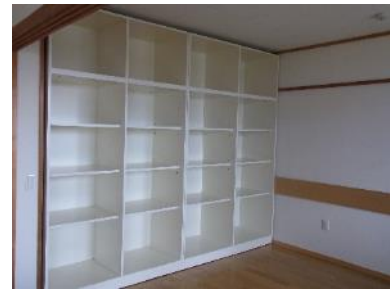
写真Ⅱ.47 可動式家具による間仕切り
