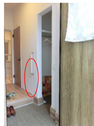
写真Ⅱ.11 上がり框部分に設置された縦手すり
