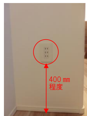
写真Ⅱ.8 通常よりも高い位置に設置されたコンセント（ハイハイする乳児の手に届きにくく、大人にとっては、屈まずに使用できる）
