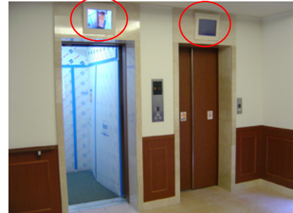
写真Ⅱ.62 エレベーターホールに設置されたエレベーターかご内の様子を把握できるモニター
