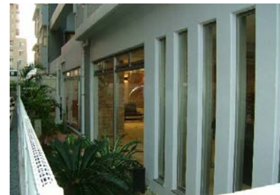
写真Ⅱ.57 注1) 外部からの見通しが確保されたエントランスホール
