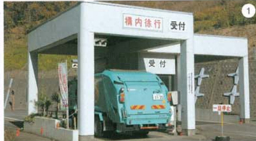
計量機…収集車のごみ重量を自動計測します
