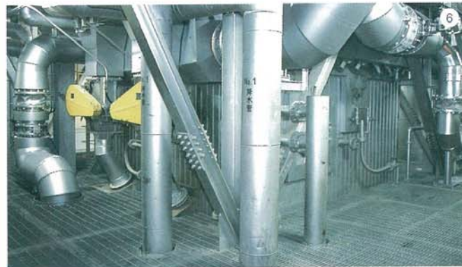
流動床式焼却炉…ごみを完全燃焼させます
