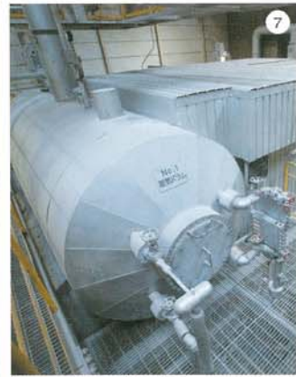
ボイラ…蒸気を発生します
