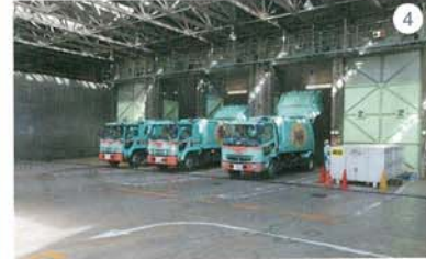
プラットホーム…ごみピットにごみを投入します
