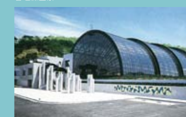
福井市東山健康運動公園全景(ドーム式温水プール等)
