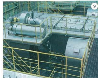
バグフィルタ…燃焼ガスをきれいなガスにします
