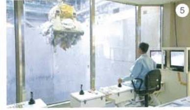
クレーン操作室…運転は手動・半/全自動遠隔操作です
