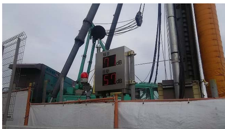
工事中における騒音・振動測定状況例
