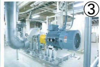
小型発電機…脱気器へ送る蒸気で発電します
