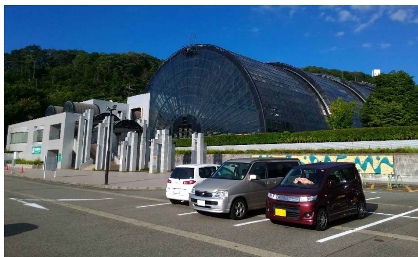
図 3-6-1 現施設の余熱利用設備及び健康運動公園温水プール外観
