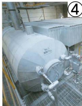
ボイラ…蒸気を発生します
