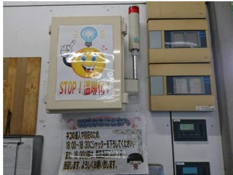
電気使用量デマンドを設置し、設定数値を超過した場合、アラーム警報が鳴る仕組みを採用している。
