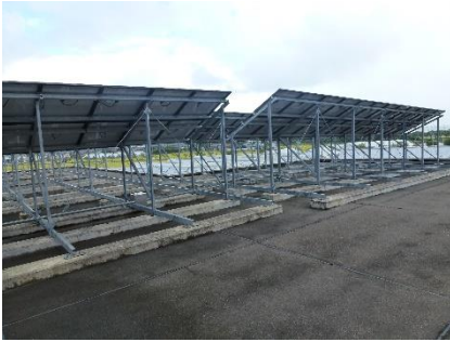
事務所の屋上に太陽光発電システムを設置
