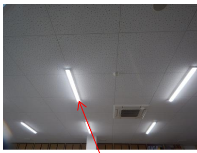
事務所内にLED照明を設置
