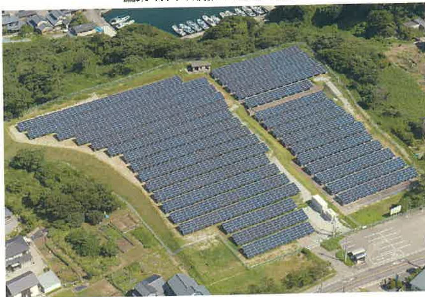
鷹巣マルツ太陽光発電所（芸町）
