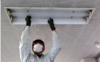
① 電気を消して、蛍光管をはずす
