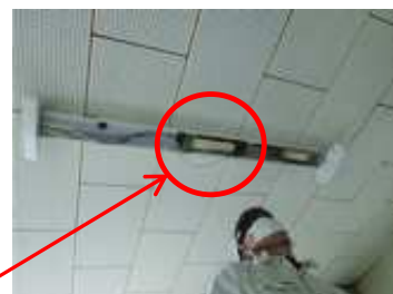
安定器 業務用蛍光灯での安定器の設置例
