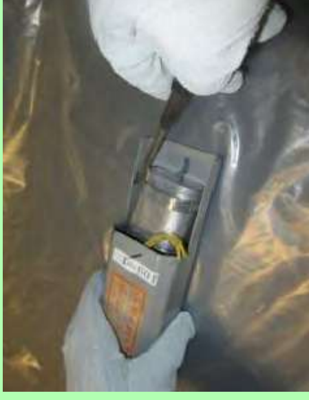
コンデンサの 取り外し作業
