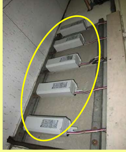
工場等の壁際に設置されてい る複数の安定器の例
