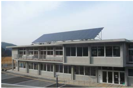
【至民中学校の太陽光発電パネル】
