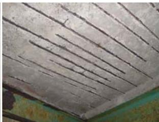
塩害による床版損傷
