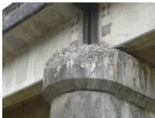
凍害による橋脚損傷
