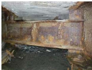
老朽化による鋼桁腐食
