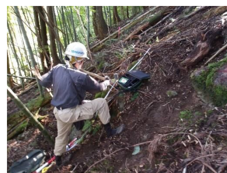
転石根入調査(比島部のみ)
