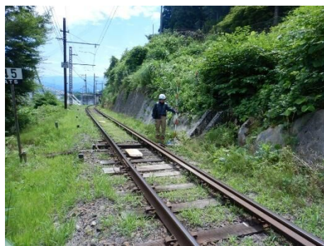
線路に隣接する法面を調査対象
