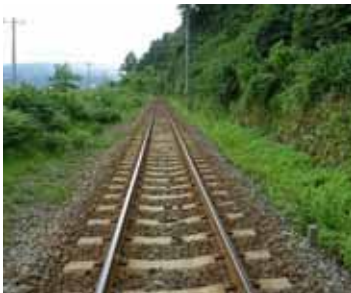
設備投資(軌道整備)のイメージ
