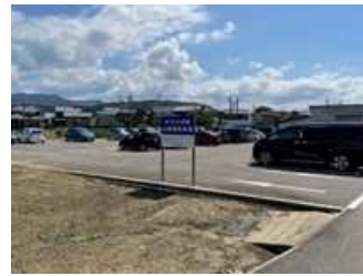
越前島橋駅 P&R 駐車場整備
