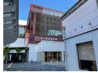
福井駅の駅舎改修
