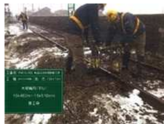
大関駅構内マクラギ更换
