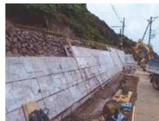
小舟渡駅付近法面補強
